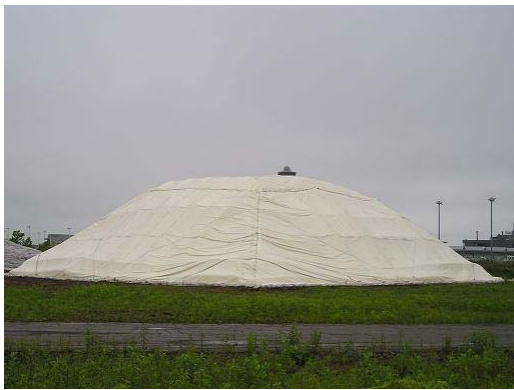
図-10 (b) 空気膜断熱被覆材の外観 (2009/6/16)
