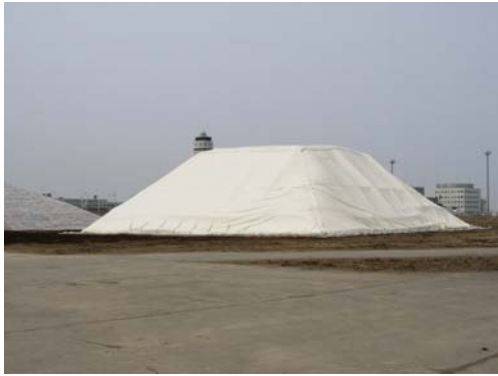
図-10 (a) 空気膜断熱被覆材の外観 (2009/4/8)
