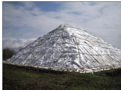
図-6 防水遮光被覆材の外観 (防水遮光シート)
